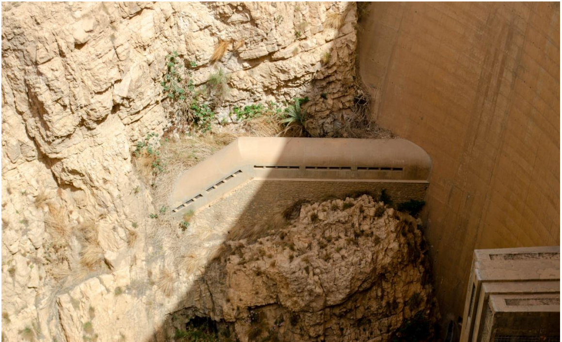
Figure. III.6. la conduite de prise d'eau du barrage(juin 2022)
