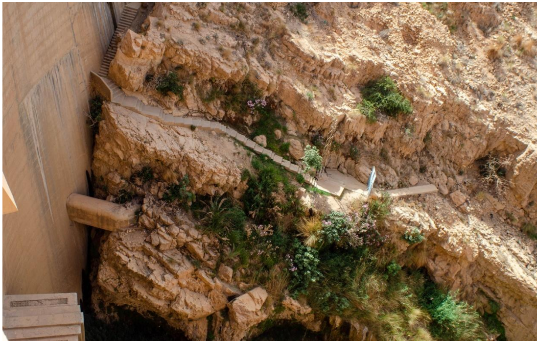
FigureIII.2.la conduite de prise d'eau (juin 2022)
