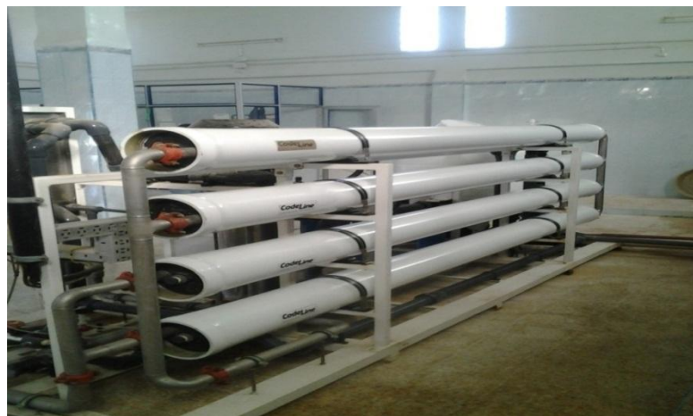
Figure 7 :Membrane de filtration par osmose inverse
