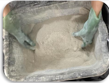
Figure. II.11. Mélanger les matières sèches.
