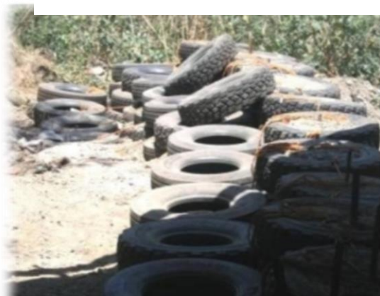
Figure I.13. Superposition et attache des penus/ de pneus.
