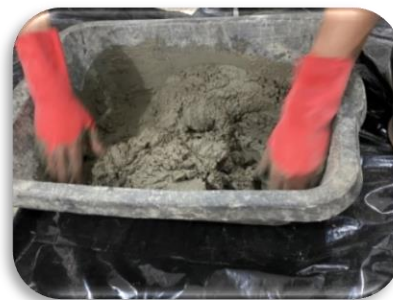
Figure. II.12. Ajouter de l'eau en mélangeant.
