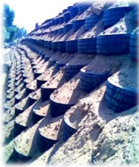
Figure I.10. Pose des nappes de pneus Projet pilote-Route de bousmail.
