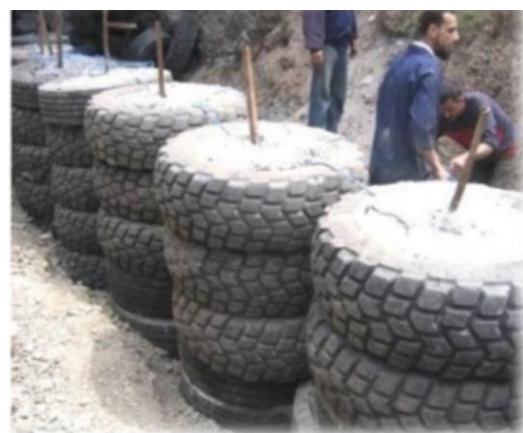
Figure I.14. bétonage de la lière file
