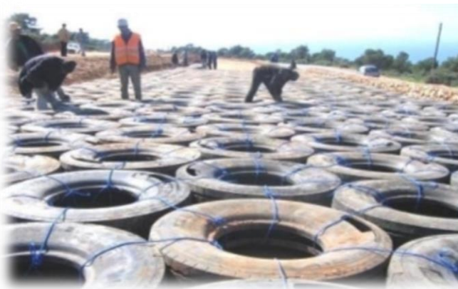
Figure I.12. Ouvrage de mostaghanem RN11 (algérie) stabilité dun talus.
