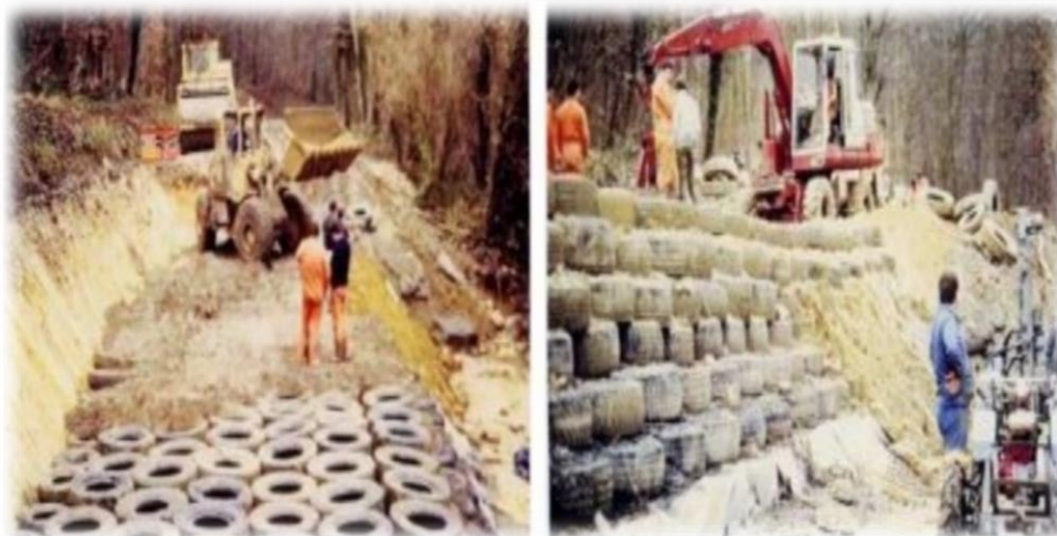
Figure I.9. La technique de pneu sol : le channes-Mandelieu en 1988
