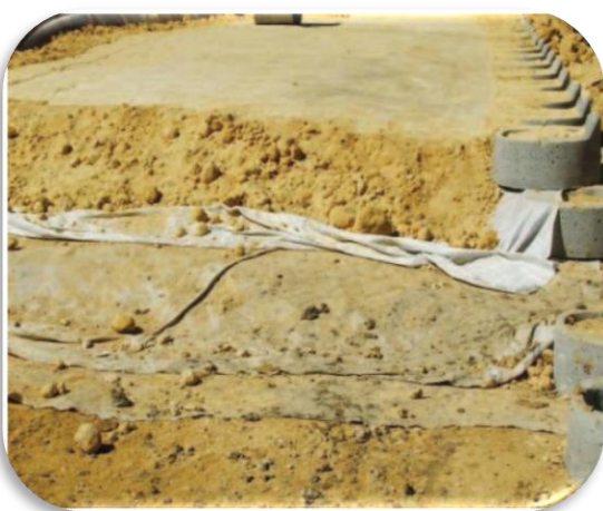
Figure II-2: ouvrage en sol renforcé
