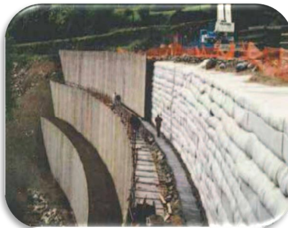
Figure II-8: Panneau de pleine hauteur (d'après Abu-Hejleh et al., 2001)
