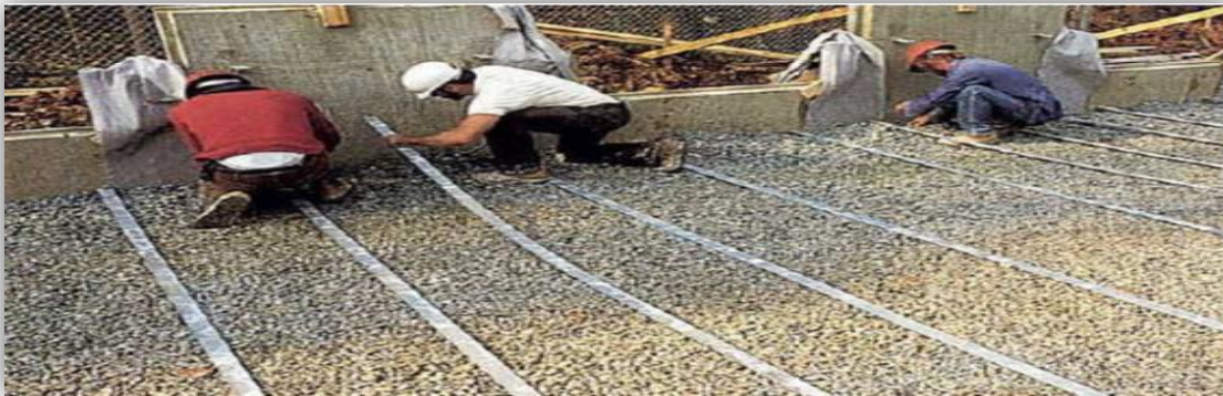
Figure II-23: Photo de la pose d'un lit d'armatures [14]
