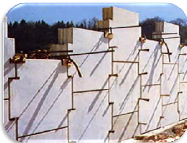
Figure II-21:Photo du montage d'un niveau d'éléments de parement
