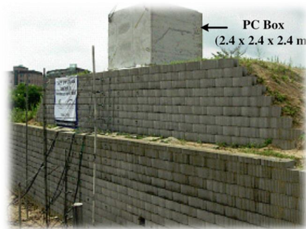
Figure IV-3: photo réel d'un mur de soutènement superposer avec chargement.
