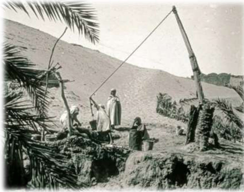
خطرة " سارية" بولاية وادي سوف تستعمل لرفع الماء من داخل البئر 2
