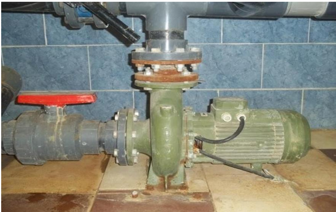
Photo 4.2 : Pompe centrifuge axial
