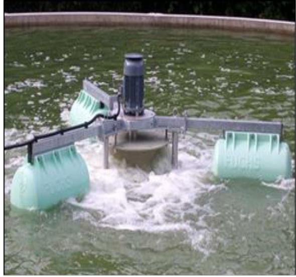
صورة رقم (23): التصفية بالبحيرات المهواة Lagunage Aéré
