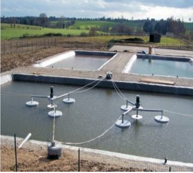
صورة رقم (23): التصفية بالبحيرات المهواة Lagunage Aéré
