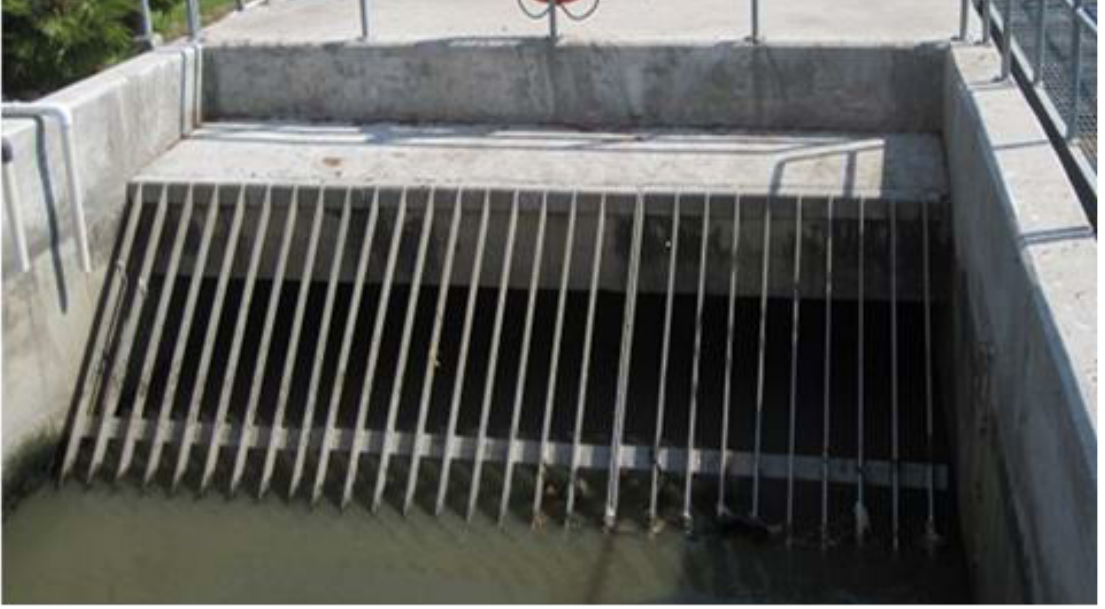
صورة رقم (17): نزع المواد الكبيرة الحجم Le dégrillage
