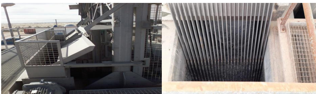
Figure (IV.5) : Dégrillage (station de Hassani Abdelkrim) (Photo originale, 2021).
