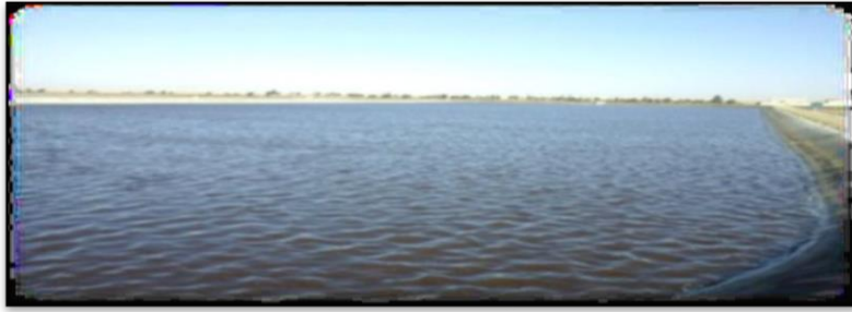
Figure (IV.9) : Lagune de finition (station de Hassani Abdelkrim) ( Photo originale, 2021 ).
