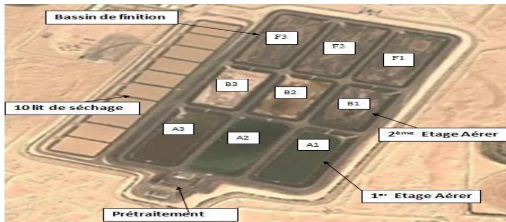
Figure (IV.3) : Stations de lagunage aéré de Hassani Abdelkrim (ONA, 2021).
