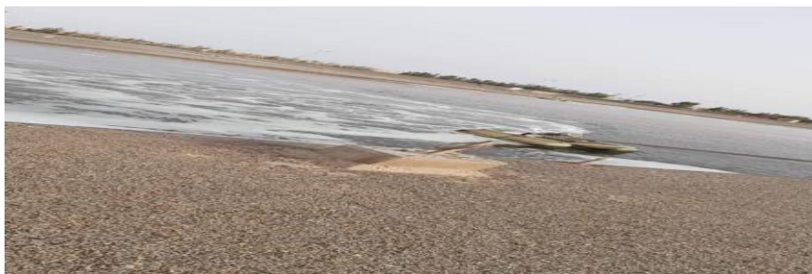
Figure (IV.8): Aérateur (station de Hassani Abdelkrim) (Photo originale, 2021).
