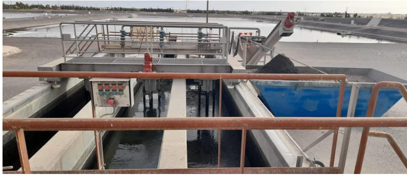
Figure (IV.6) : Dessablage (station de Hassani Abdelkrim) (Photo originale, 2021).
