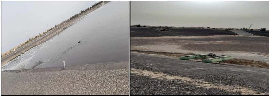
Figure (IV.7) : Lagune aérée (station de Hassani Abdelkrim) (Photo originale, 2021).
