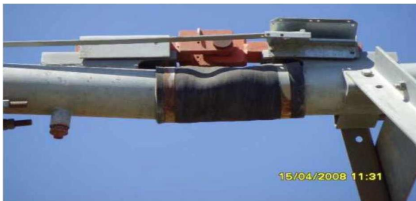
Figure I. 6 Élément de liaison entre travée [1].
