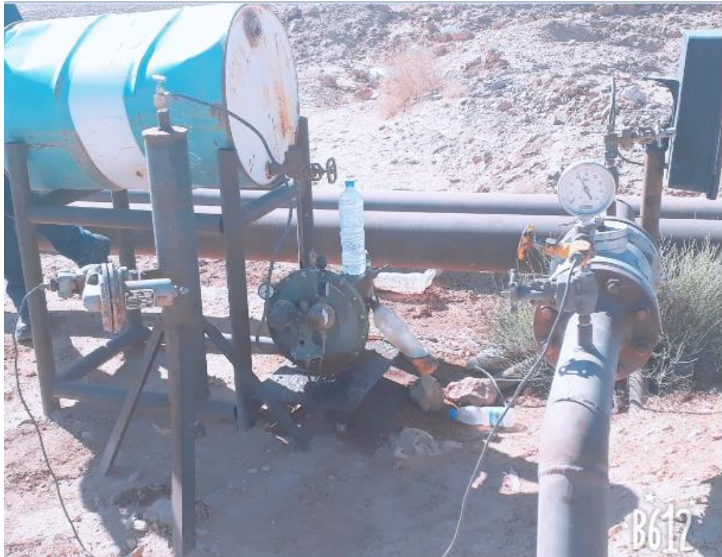
Figure IV.1. L'injection de di-éthylène glycol dans le champ TFT.
