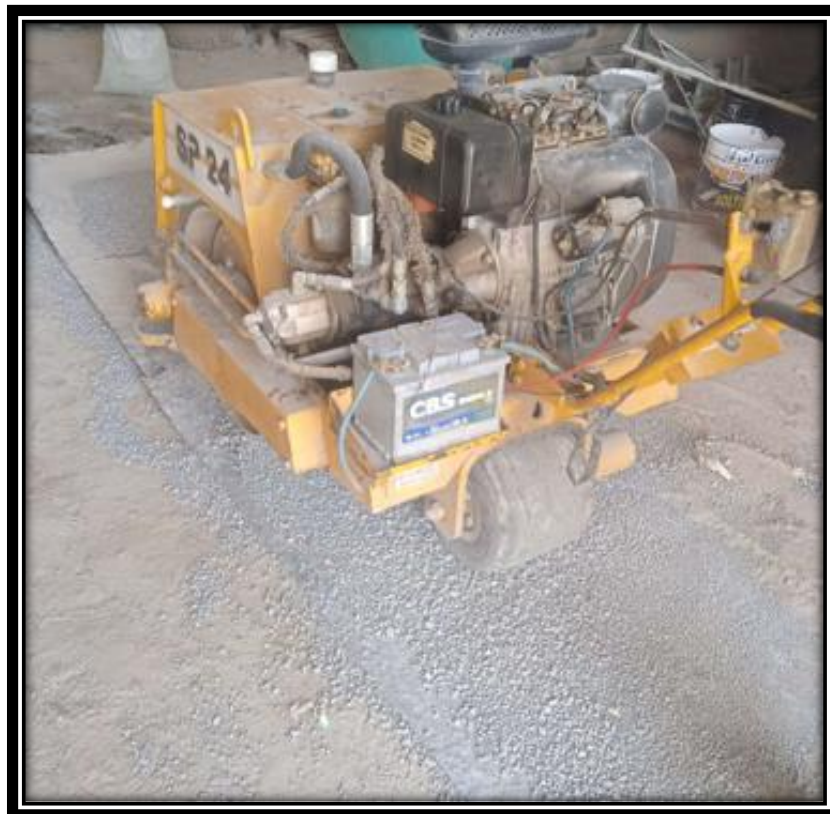
Figure II .10 : préparation des granulats de béton de démolition.
