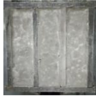
Figure II.31 : Dernière vibration et rasage
