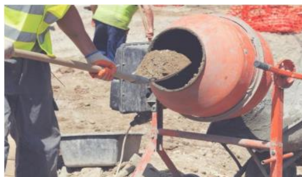
Figure I. 3 : Exemple d'une fabrication des mortiers mécanique [7].
