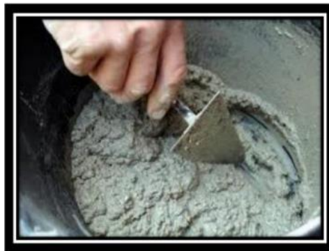
Figure I.1: Exemple d'un gâchait de mortier [3]
