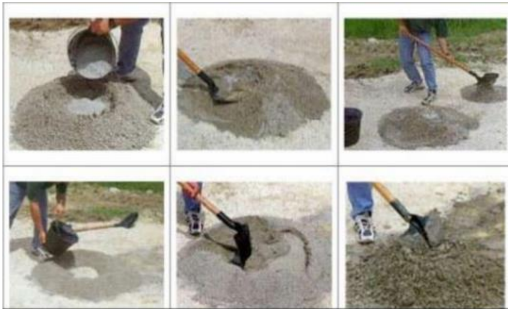
Figure I.2: Exemple d'une fabrication des mortiers à la main [6]
