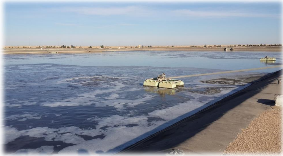
Figure(II.5) : Lagune aérée.
