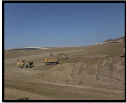
الشكل رقم 14: صورة توضح مرحلة تغطية النفايات بالرمال
