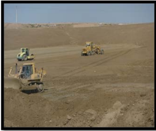
الشكل رقم 14: صورة توضح مرحلة تغطية النفايات بالرمال
