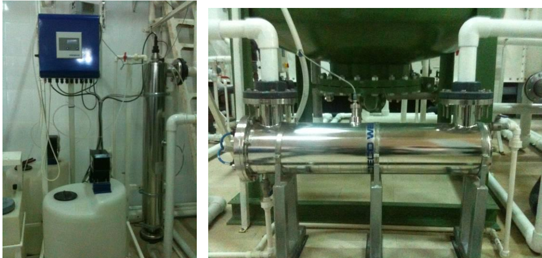
Figure IV.8 Image réel du Stérilisateur U.V. et Injecteur de Chlore ( Javel )
