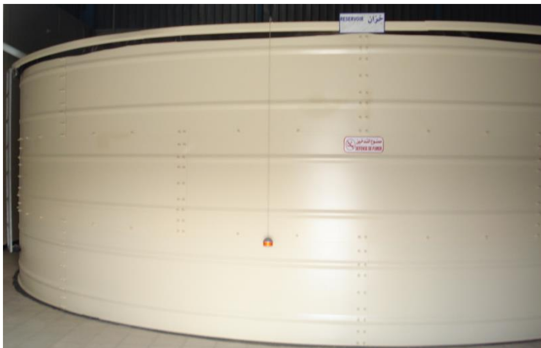
Figure IV.1 Réservoir D'eau Brute avant la Traitement
