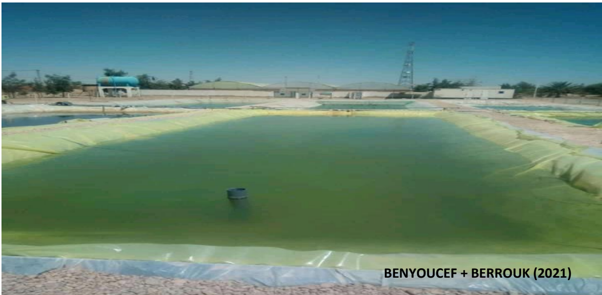
Bassins géo membranes
