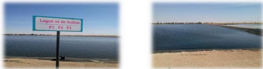
Figure15: Lagune de finition (ONA, 2009).
