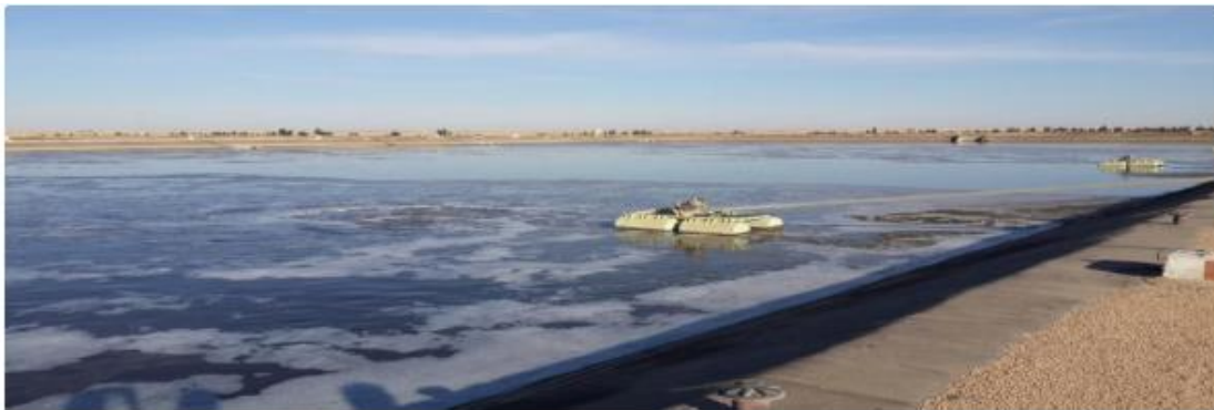
Figure14: Lagune aérée (ONA, 2009).
