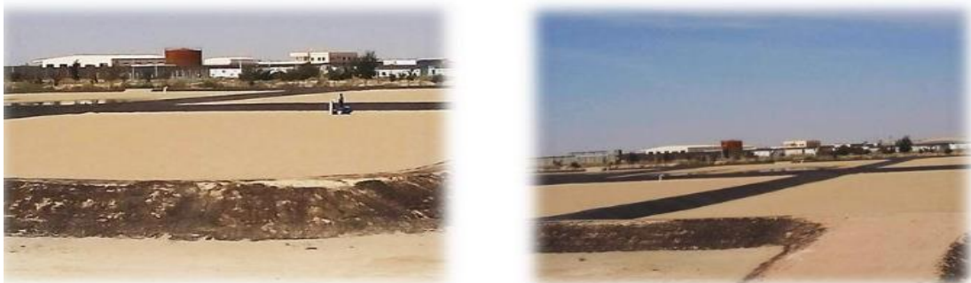
Figure 16: Lit de séchage des boues(ONA, 2009).
