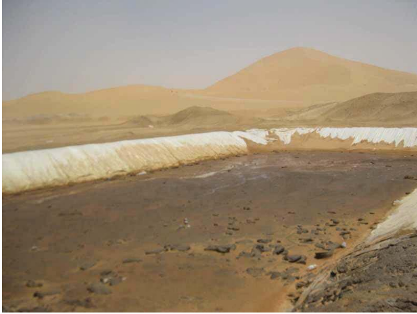
الصورة 2.I: صورة المستنقع بعد عملية الحفر.
