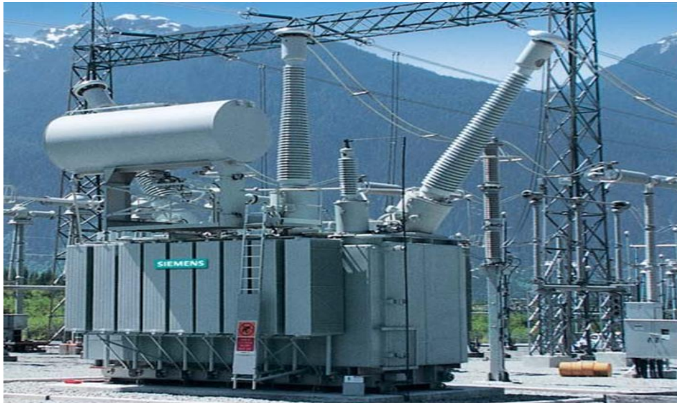
Fig.III.3:Energisation ligne avec self.
