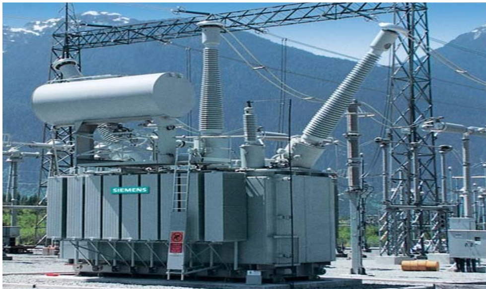
Fig.III.3:Energisation ligne avec self.
