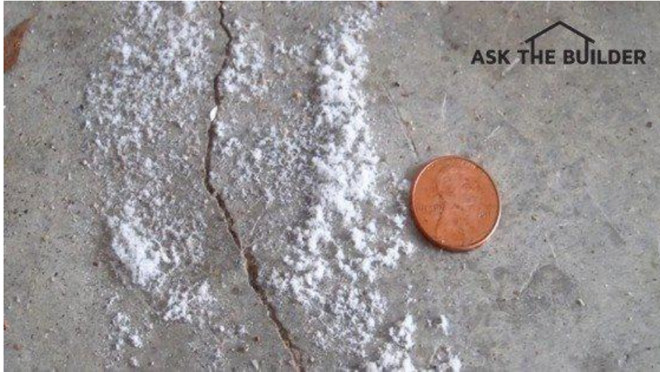
الصورة رقم (15): ظهور شقوق شعرية بسبب مهاجمة الكبريتات للخرسانة
