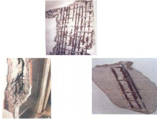
صورة (20): تآكل حديد التسليح في الخرسانة
