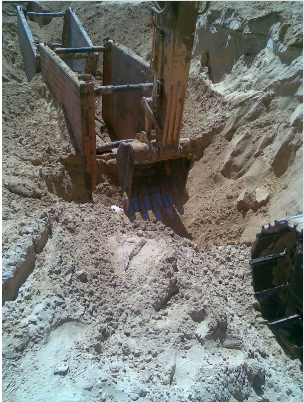
Figure V-3 : photo d'excavation de la tranchée
