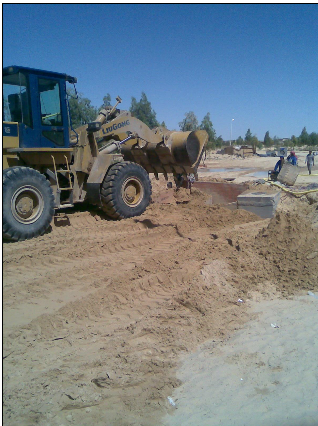
Figure V-6 : Photo remblaiement de la tranchée
