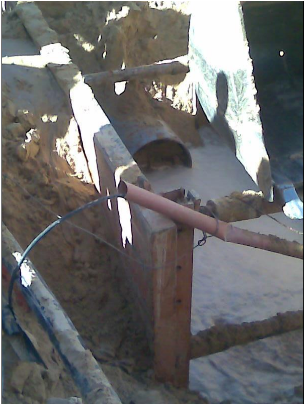
Figure V-5 : Photo sur la pose de la canalisation.
