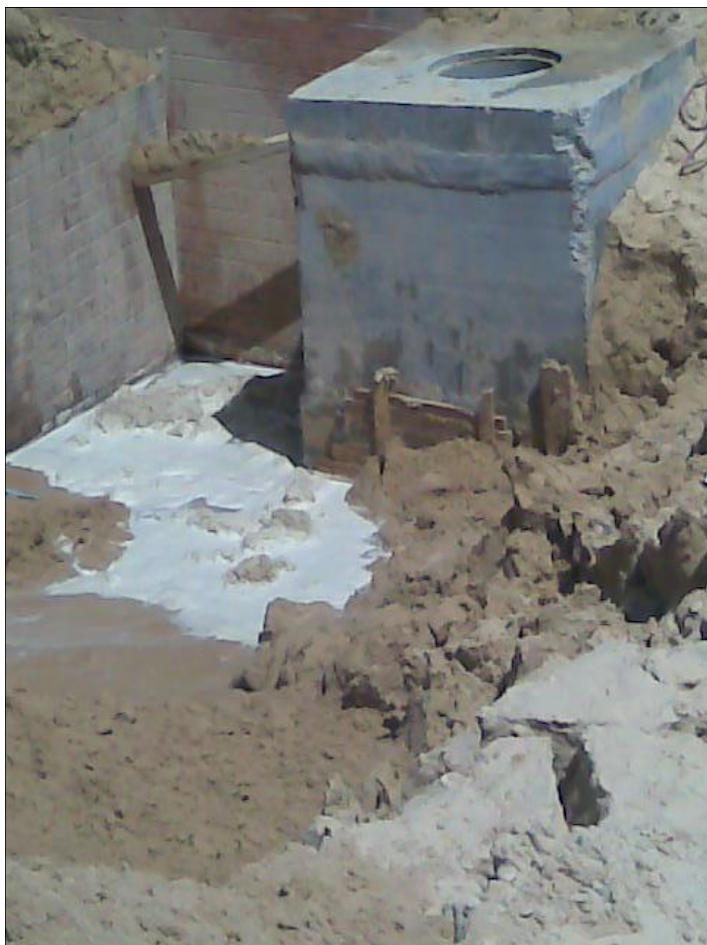
Figure V-4 : Photo du Pose du regard
