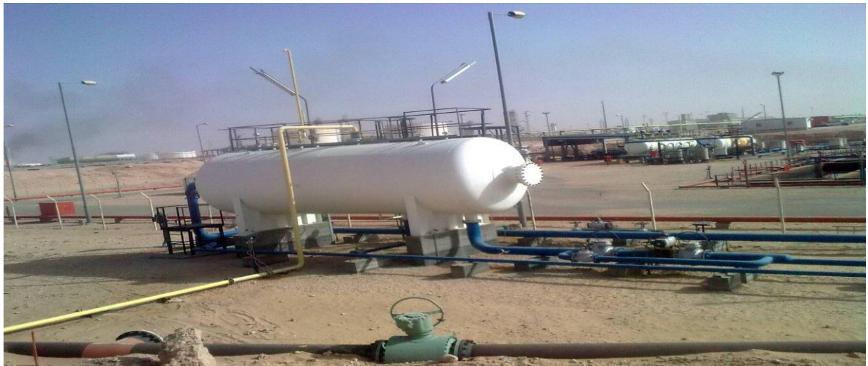
Figure 1-3 le séparateur tri phasique
