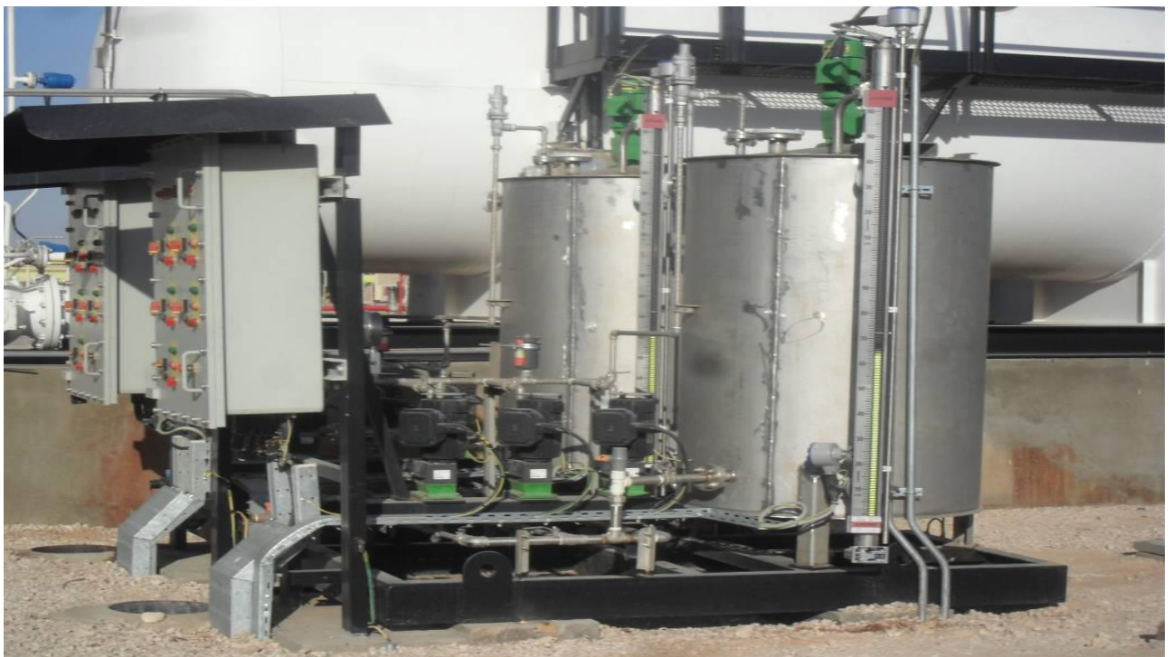
Figure 1-13 Le skid produit chimique
