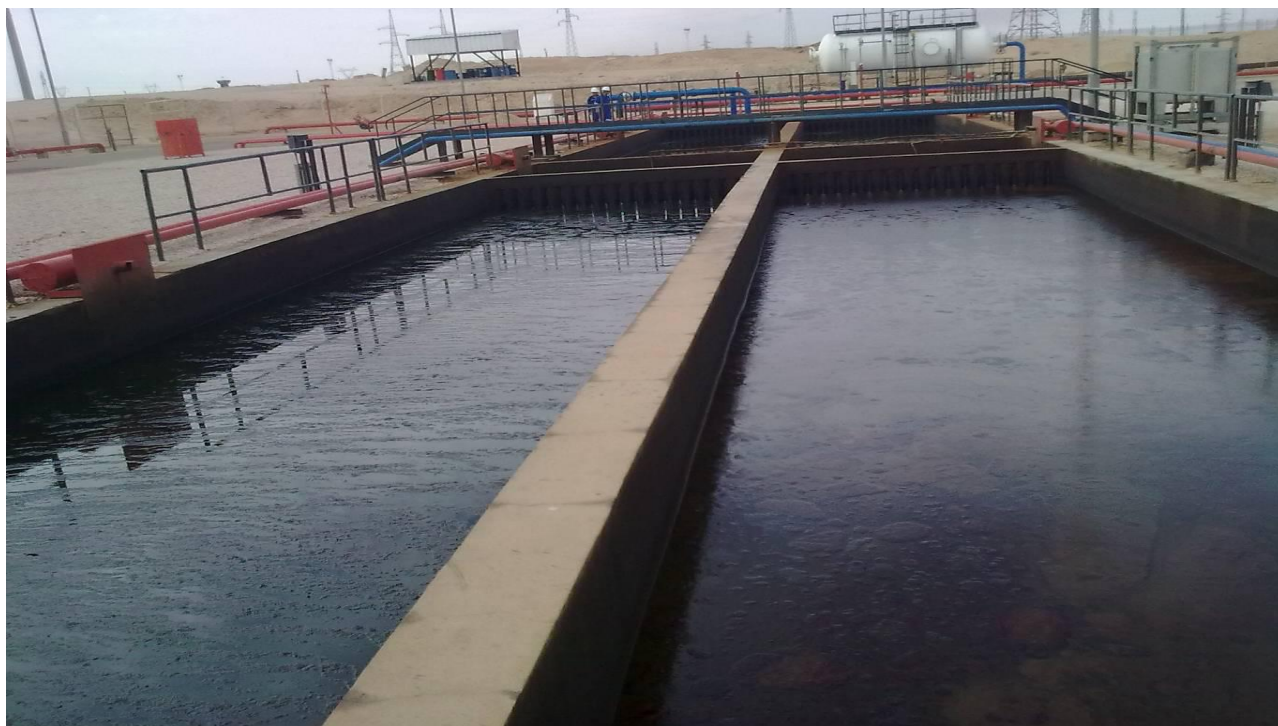
Figure 1-5 le bassin api
