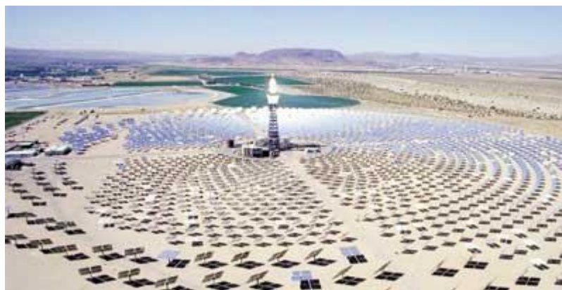
Fig.12: Centrale thermique à tour [12].
