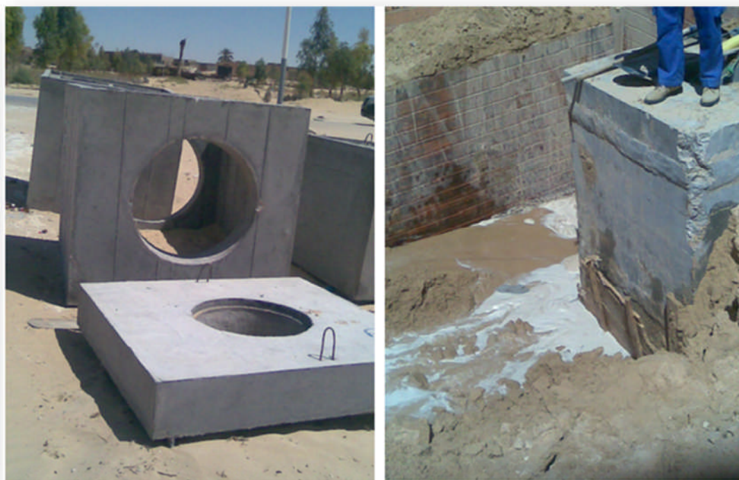
Fig. n°v.5: Construction des ouvrages surplace.
