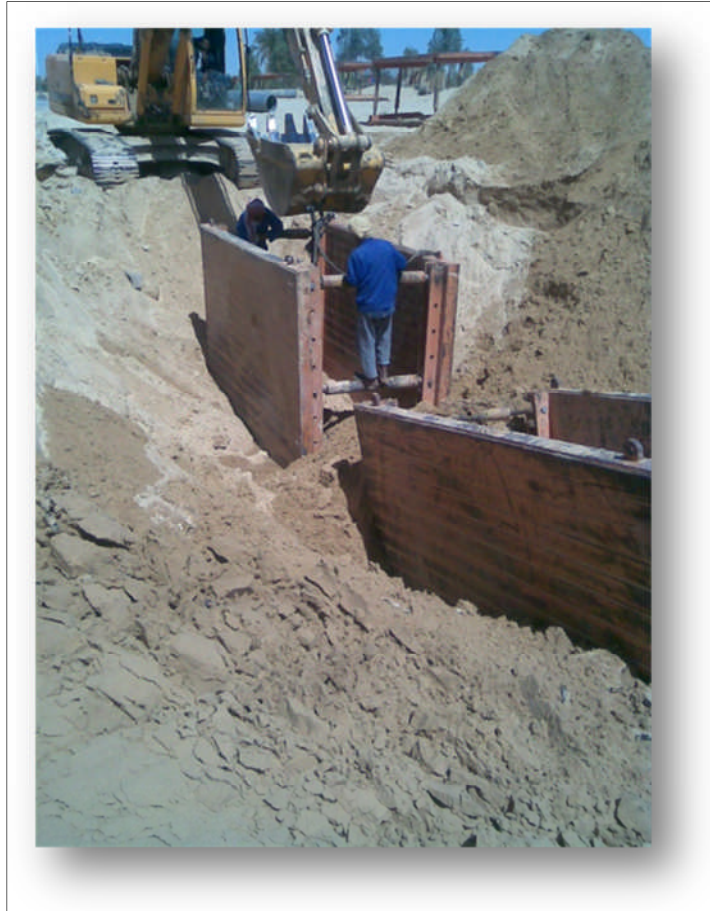
Fig. n°v.1 : La protection contre les éboulements.
