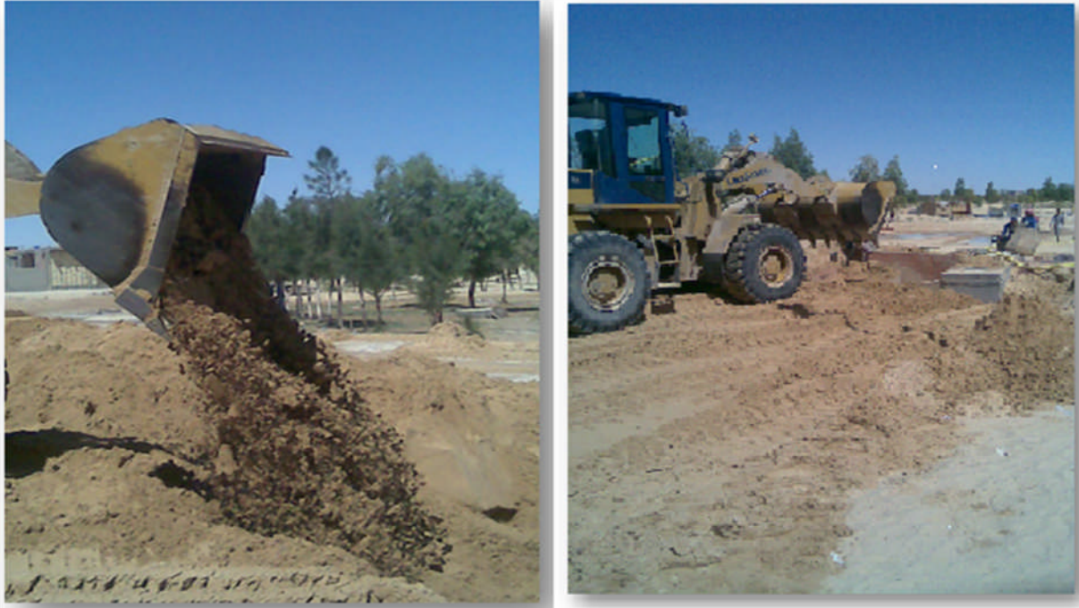
Fig. n°v.4: Remblaiement des tranchées.
