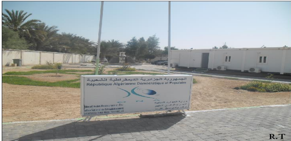
Photo 1 : photo de la station d'épuration de Touggourt.(TAREK et RACHID, 2015)
