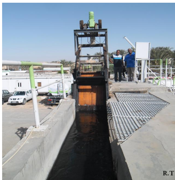
Photo 2: Degrilleur mécanique.
