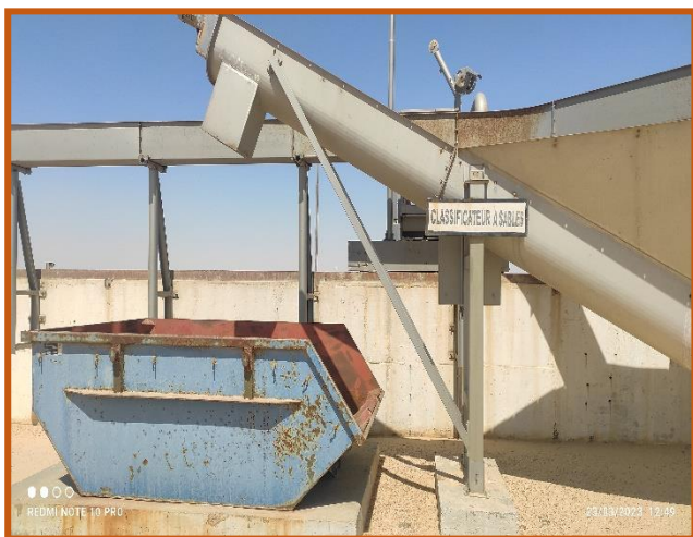
Photo N° II. 02: Classificateur de sable.
