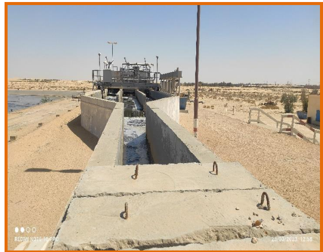
Photo I.01 : prétraitements des eaux usées
