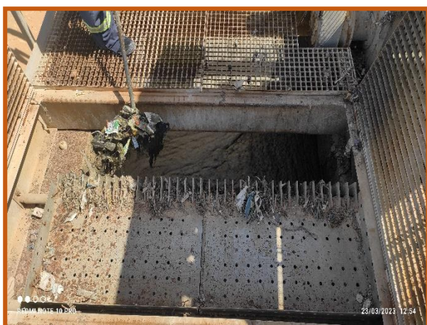
Photo N° II. 01: Dégrillage.
