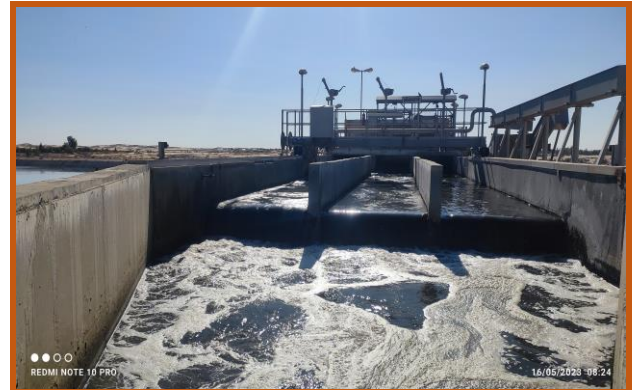
Photo I.03 : schéma d'un dessableur
