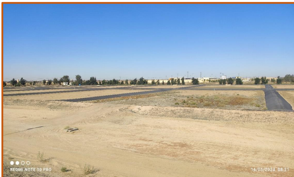
Photo N° II. 06 : Lit de séchage des boues.
