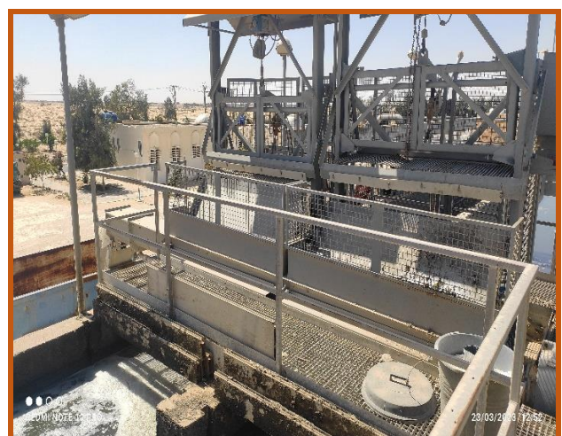
Photo I.02 : Schéma d'un Dégrilleur
