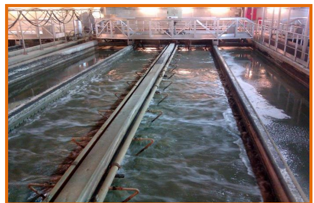
Photo I.04 : schéma d'un dégraisseur
