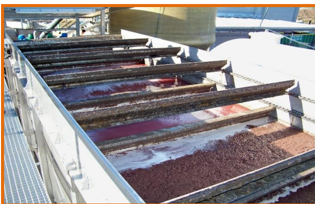
Figure I.08 : schéma d'un dégraisseur
