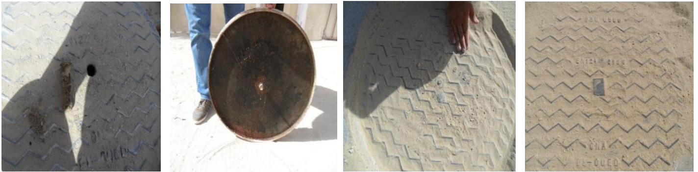
PHOTO II.5 : Fermeture des trous des regards
