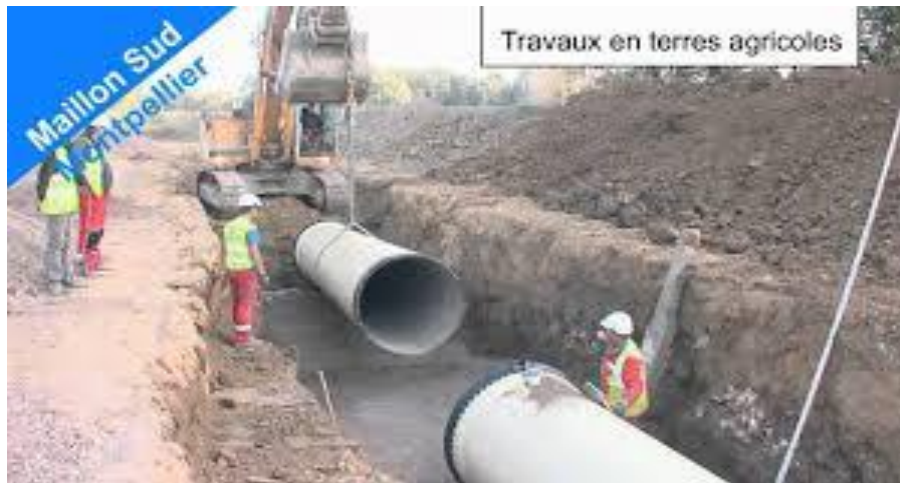
PHOTO VII.6. Pose de la canalisation.
