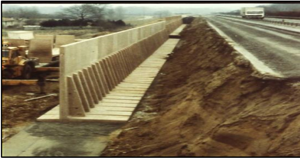
Figure 1.5 : Mur en « T renversé » classique.
