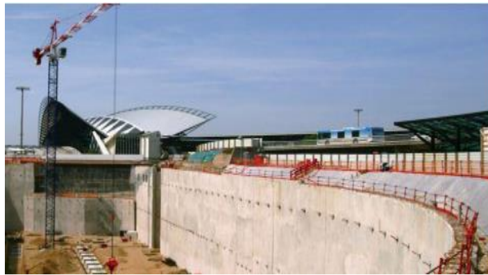
Figure 1.7 : Mur à parois moulés [4]
