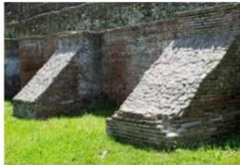
Figure 1.6 : Mur à contreforts [4]
