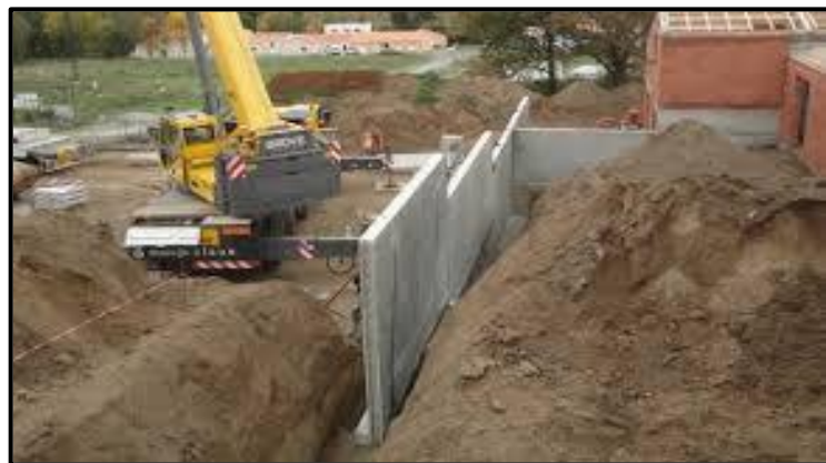
Figure 1.11 : mur en terre armé
