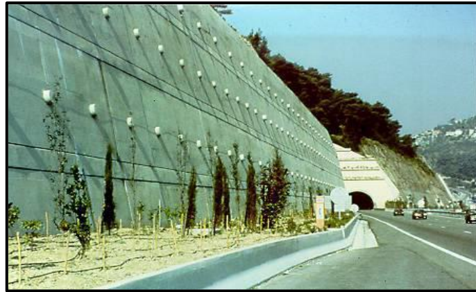
Figure 1.10 : mur coulé en béton [4]
