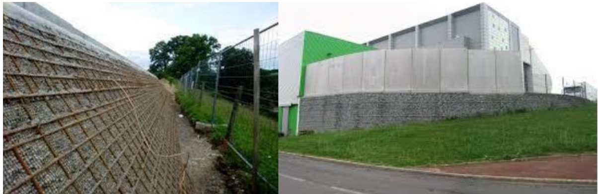
Figure 1.13 : façade de mur de soutènement
