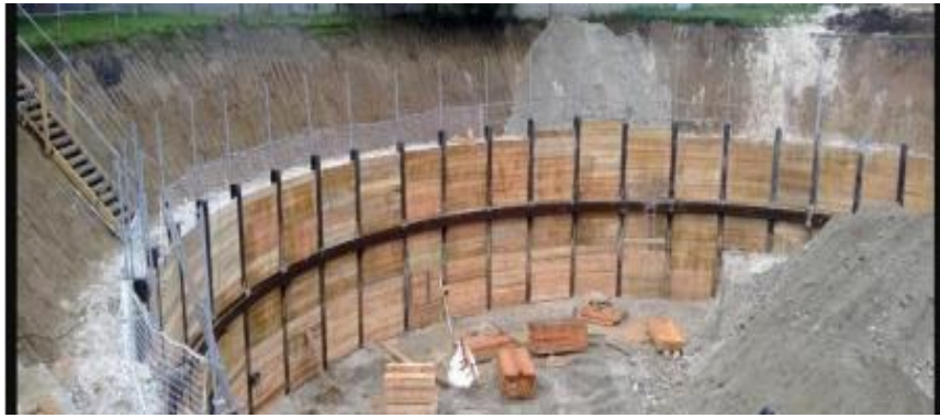
Figure 1.8 : Renforcement par titrant [4]
