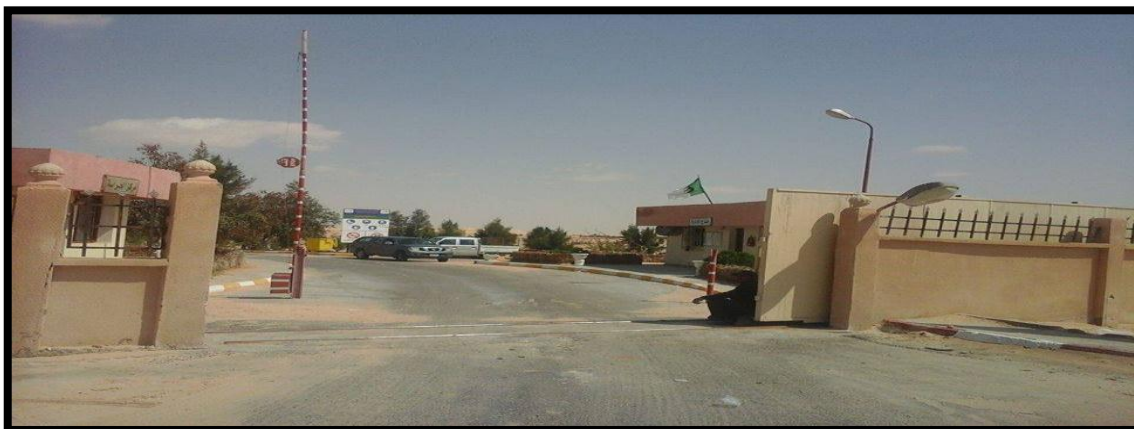
Centre Enfouissement Technique d'El Oued (CET)
