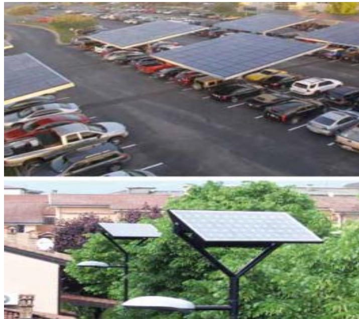
Figure II.2. Abris et éclairage public photovoltaïques [21].
