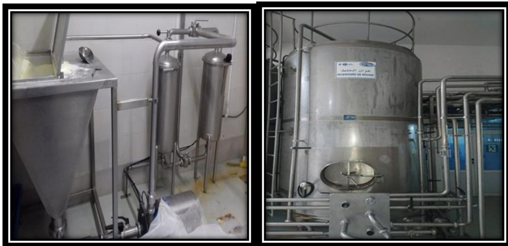
Figure19: Chambre de mélange et réservoir de mélange (PHOTO ORIGINALE, 2021).
