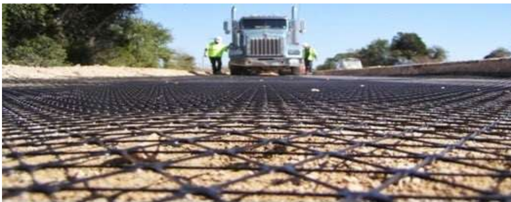
Figure I.10 : Application de géogrille dans la construction routière[19]
