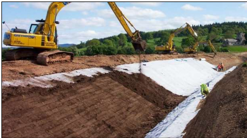
Figure I.17 : Installation de géotextile lors de travaux de terrassement[21]
