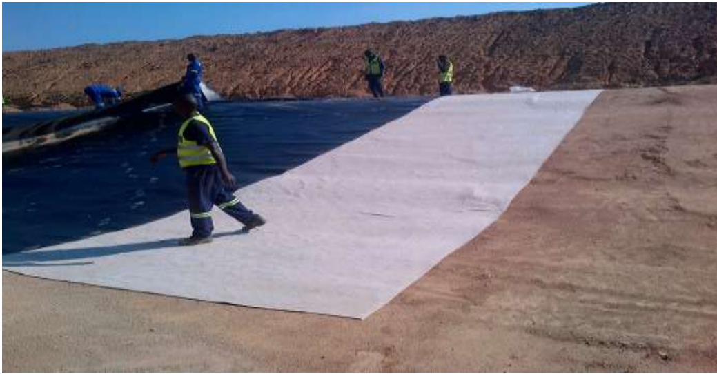
Figure I.13 : Pose de géosynthétique sur le sol[19]
