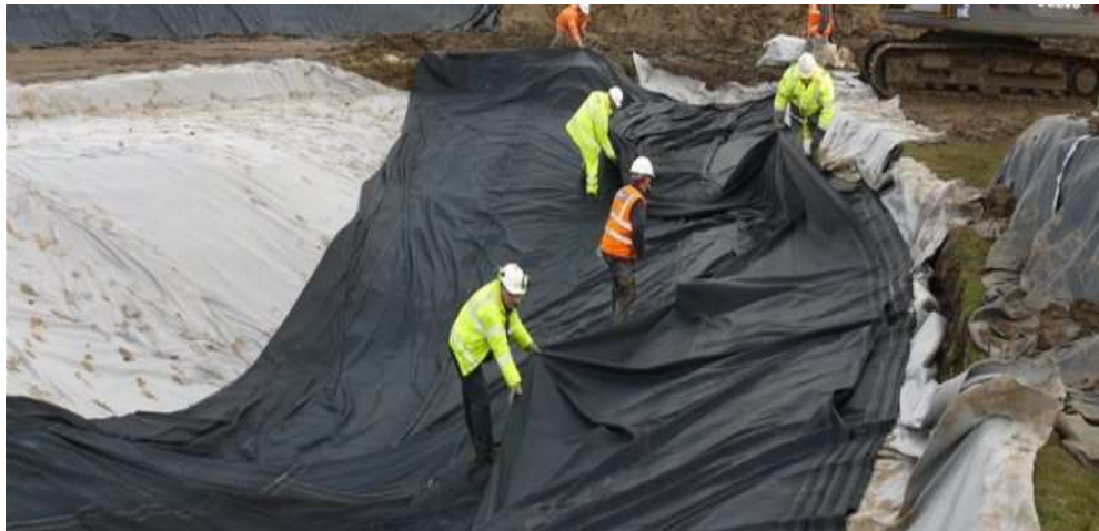
Figure I.12 : Pose de géomembrane par une équipe sur un site de confinement[19]
