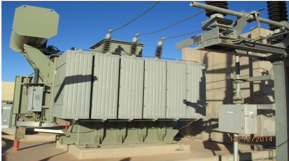
Figure (I.21) La cuve d'un transformateur de puissance.
