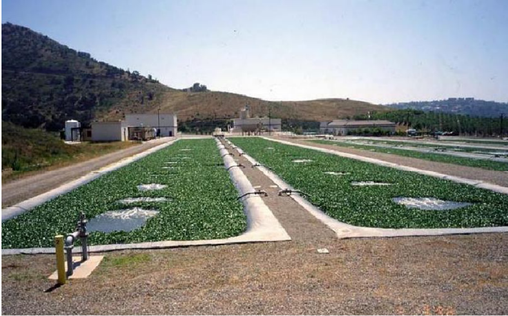
الشكل (1.II) : يبين إحدى محطات المعالجة بالنباتات الطافية بالولايات المتحدة الأمريكية [9]
