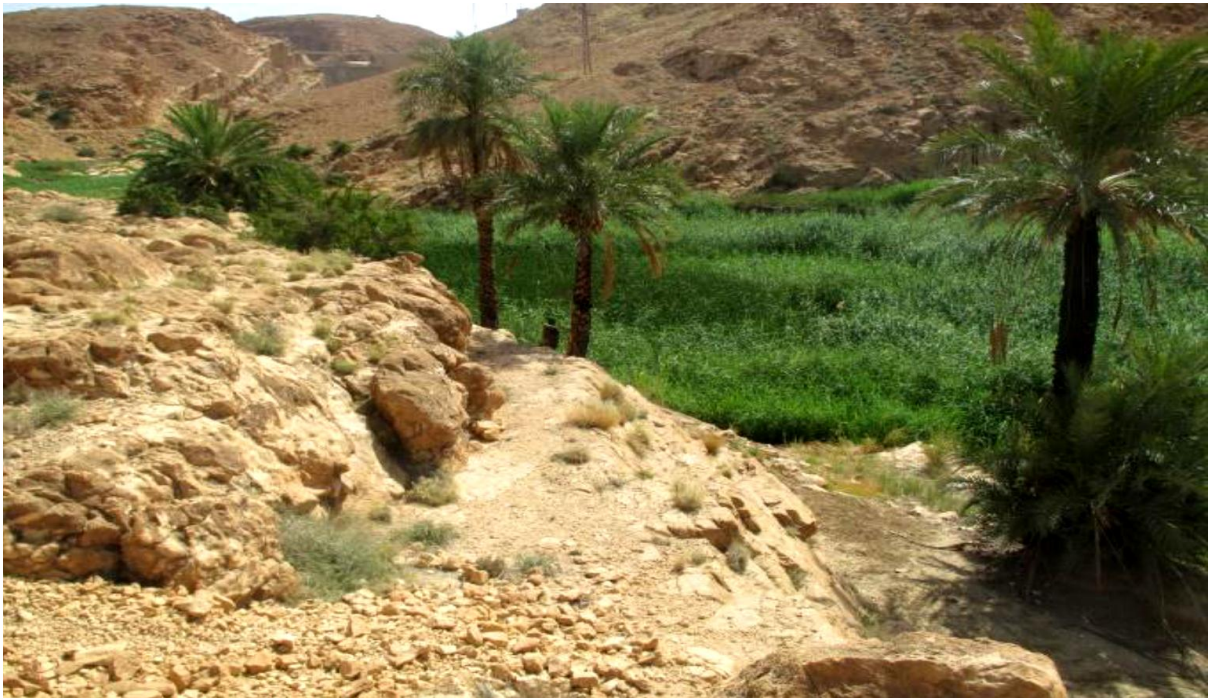
Figure 2.8 : Une aire verte s'est formée à l'aval du barrage suite aux écoulements des eaux de fuites (Remini, 2016)
