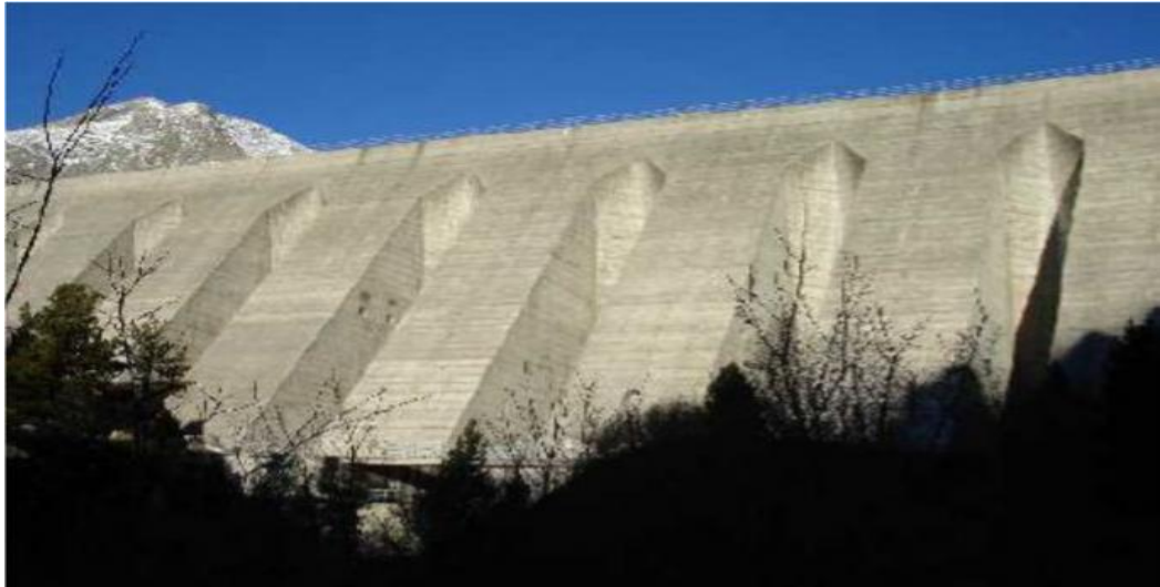
Figure 1.8: Barrage poids à contreforts de Plan d'Amont (Aussois)
