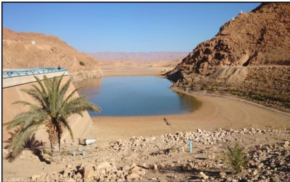
Figure 2.6: Etat critique du barrage de Fom El Gherza en Novembre 2014
