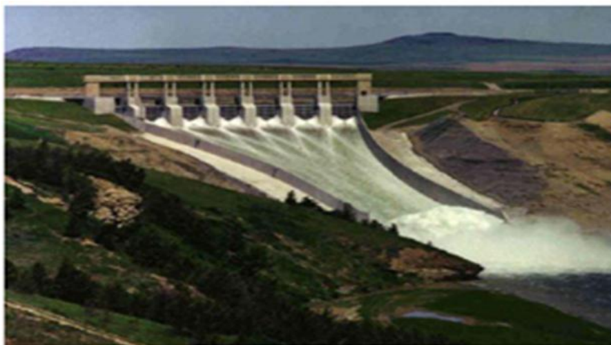
Figure 1.17 : Évacuateur de crues de surface.
