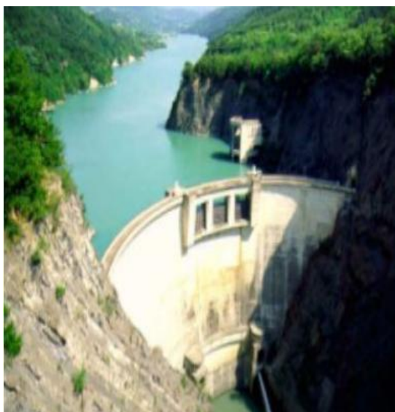
Figure 1.11 : Exemple d'un Barrage voûte (barrage de St-Pierre Cognet)
