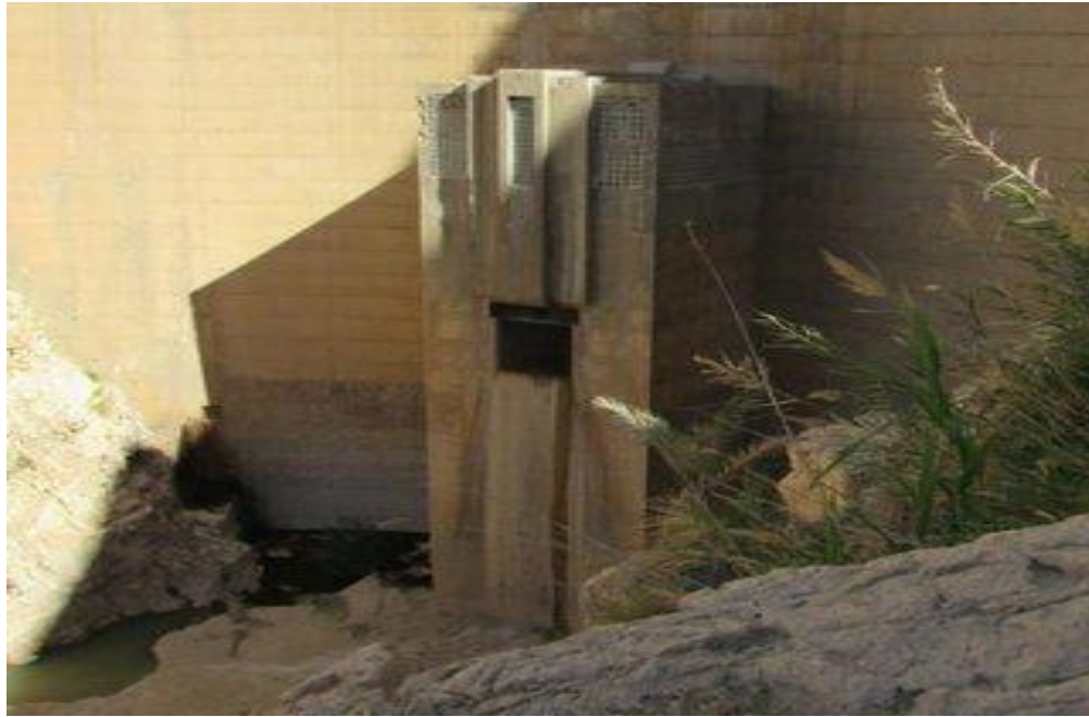
Figure 2.19 : Déversement d'une crue accompagné d'une opération de vidange de fond
