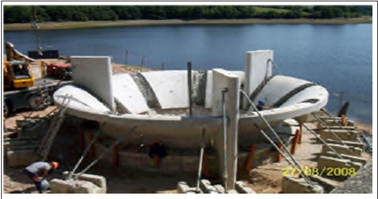
Figure 1.23 : Évacuateur en puits circulaire.
