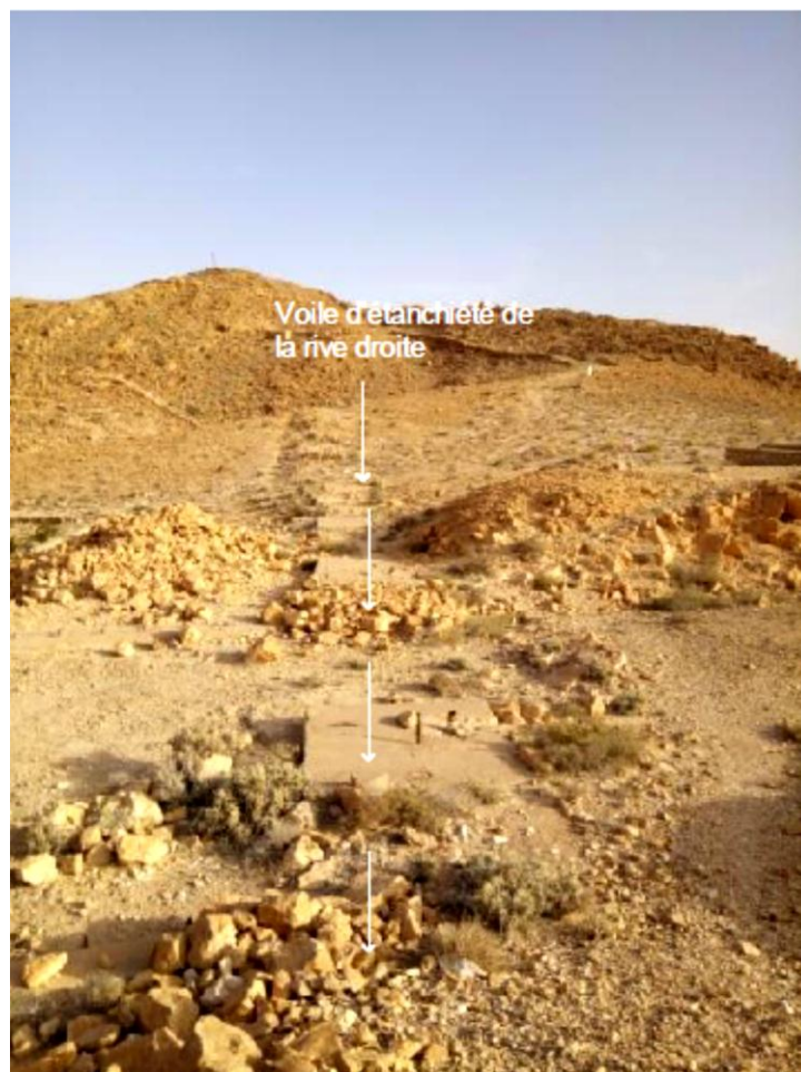
Figure 2.13 : Traces du rideau d'étanchéité sur la rive droite du barrage (photo. Mai 2017)
