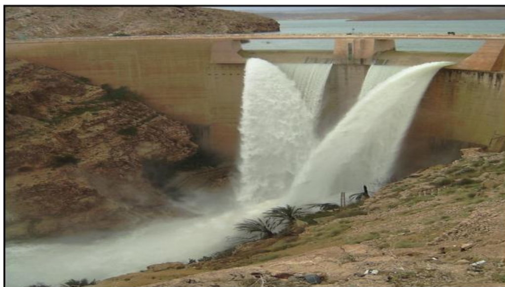
Figure 2.18 : Evacuateur de crue du barrage de Fom El Gherza en plein déversement
