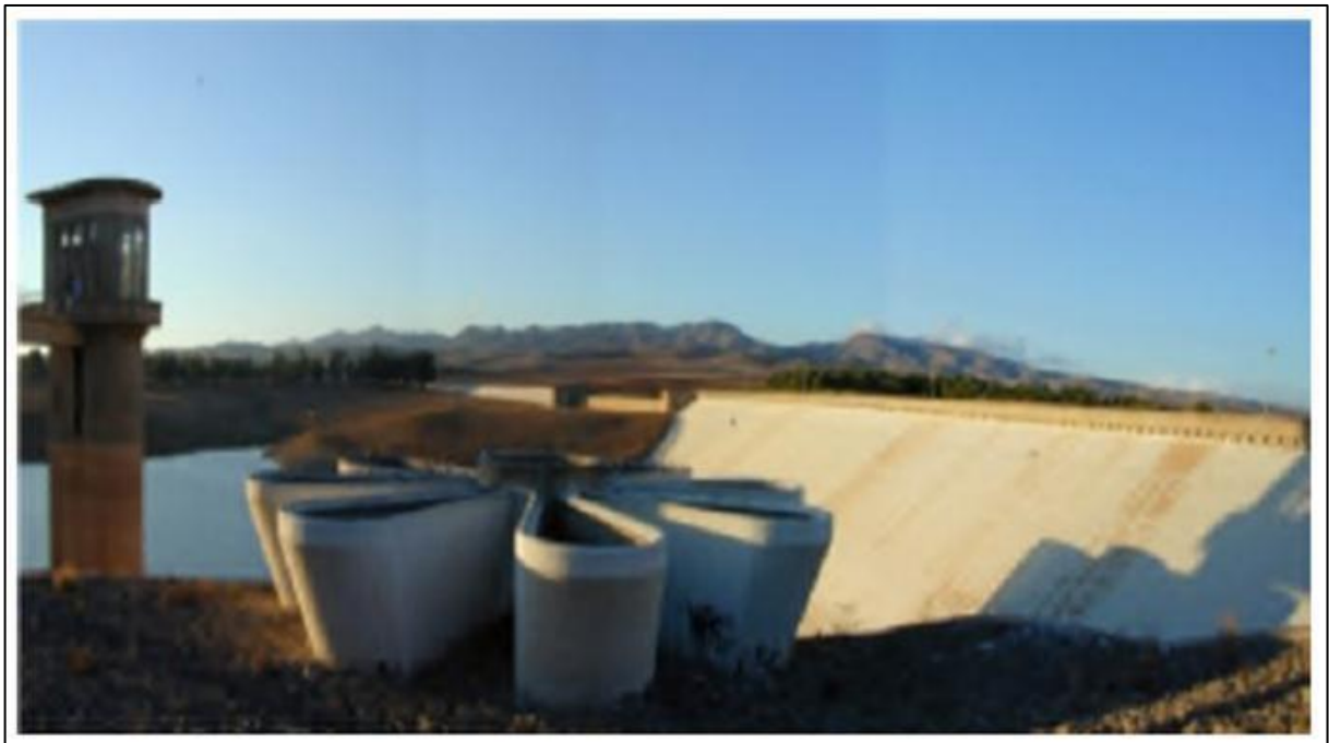
Figure 1.24 : Évacuateur en puits marguerite.
