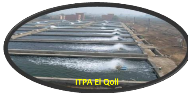
Figure 08: Bassin en béton
