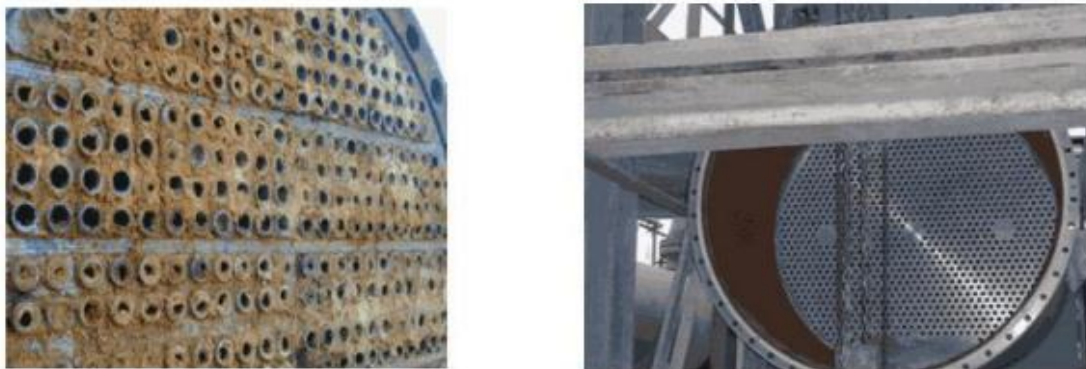
Fig.II.1: Echangeur propre (à droite) et échangeur sale (à gauche).
