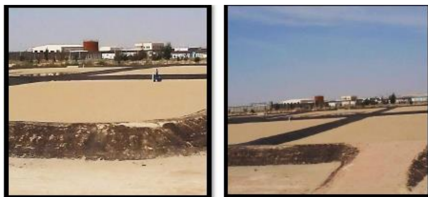
Figure.14. Lit de séchage des boues.
