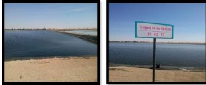
Figure.13. Lagune de finition.
