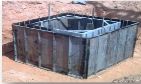
Figure VI-7: Réalisation du regard.
