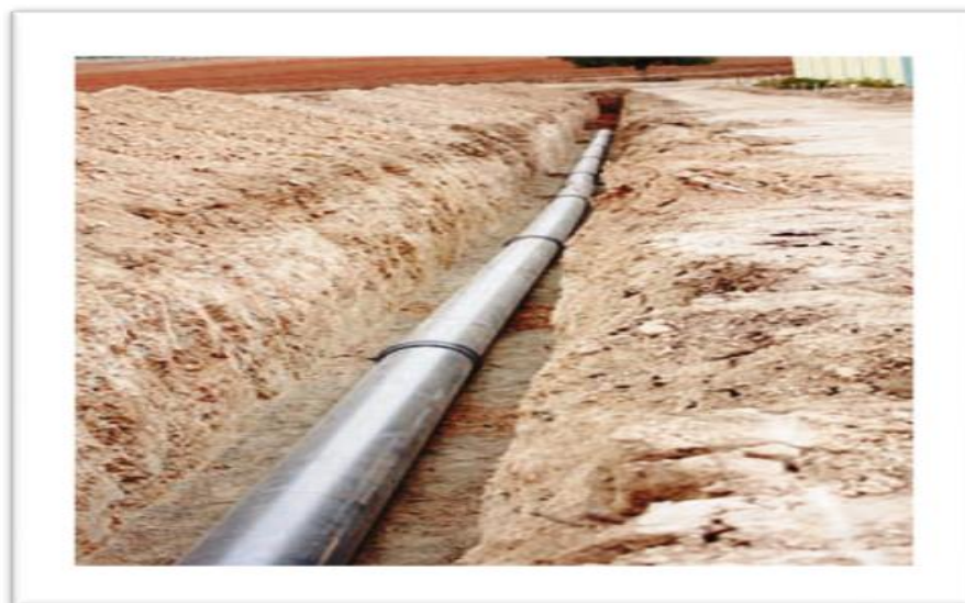
Figure VI-4: Pose des canalisations en tranchée.
