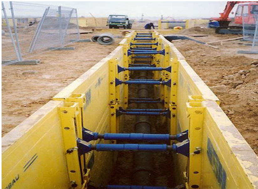
Figure VI-5: Blindage des tranchées.
