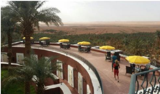
Fig. 4. Les terrasses de l'hôtel Gourara Timimoune. Vue sur la palmeraie
