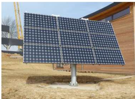
Figure I.30 Champ photovoltaïque avec poursuite solaire [12].
