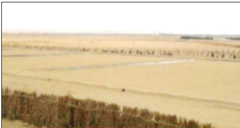
Figure 16 : Lits de séchage des boues (ONA, 2019)
