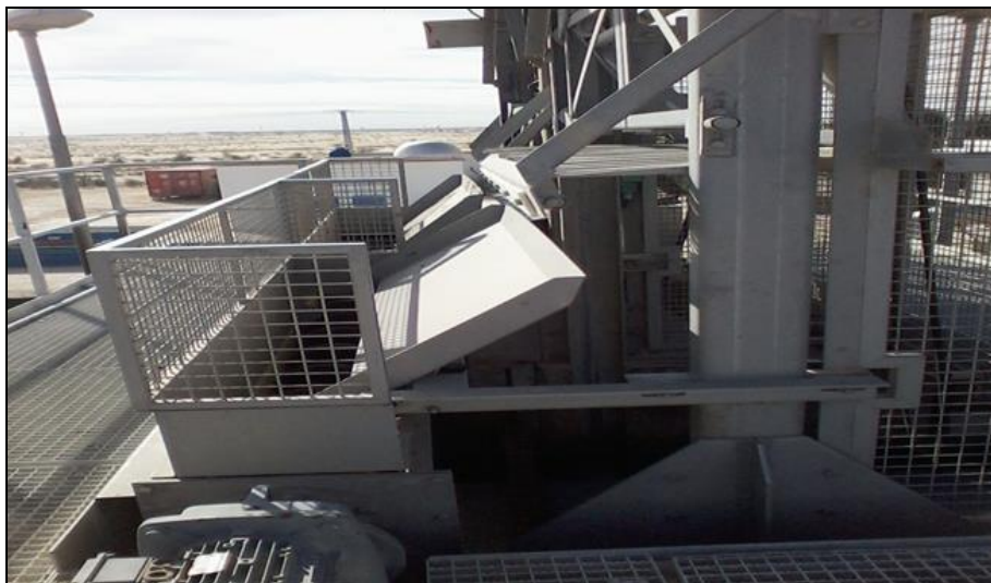
Figure 11 : Dégrillage (ONA, 2020).
