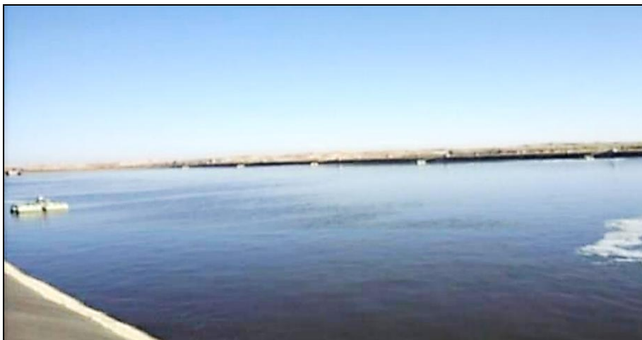
Figure 14 : Lagunes aérée –deuxième étape (ONA, 2019)
