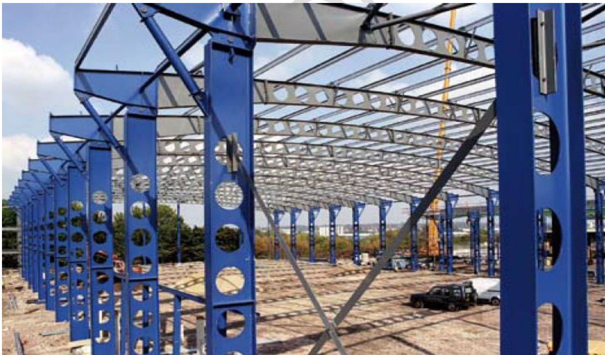
Figure 4.11. Poutres cellulaires à assemblages innovants
