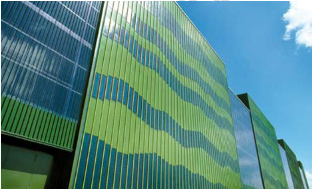
Figure 4.32. Façade avec panneaux solaires intégrés.
