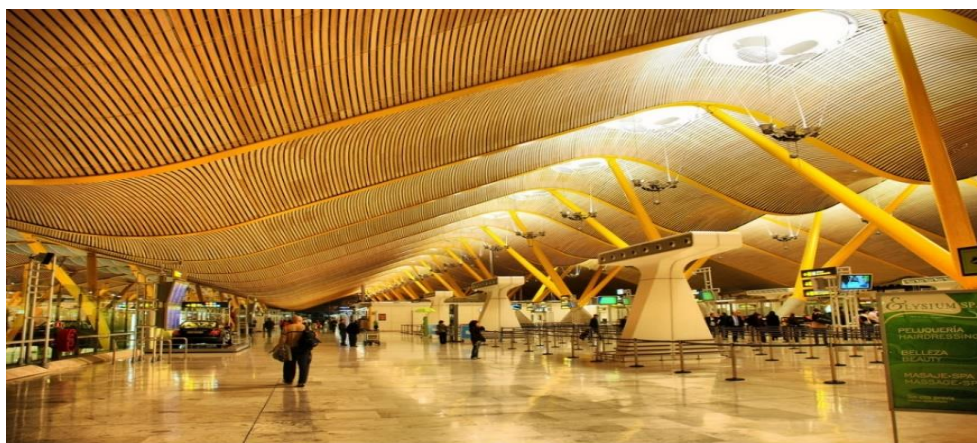
Figure I-11 : Applications novatrices des bio composites à base de fibres de bambou au sein de l'aéroport de Madrid-Barajas [55].
