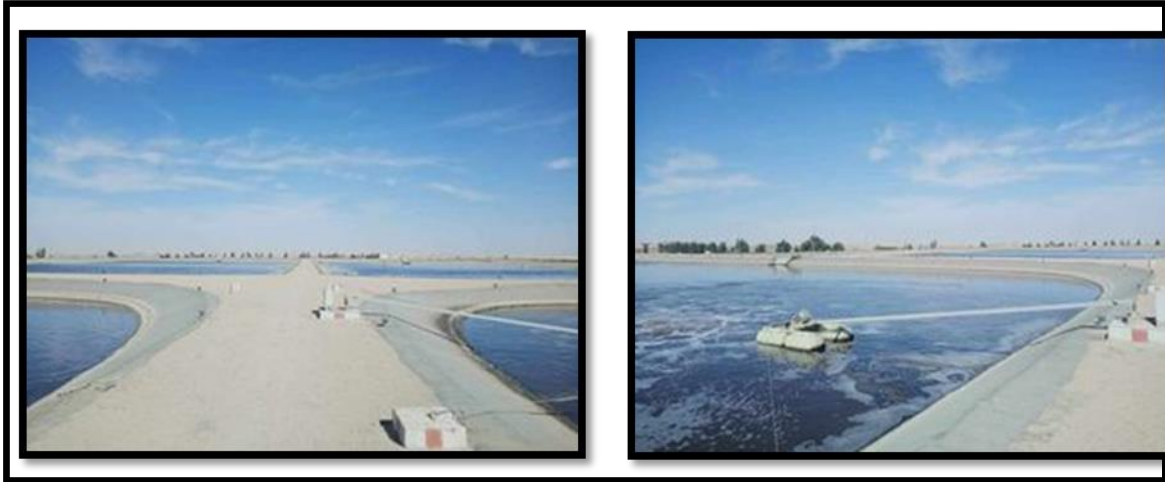
Photo05 : Station d'épuration des eaux usées de Kouinine (C.F. 2022)
