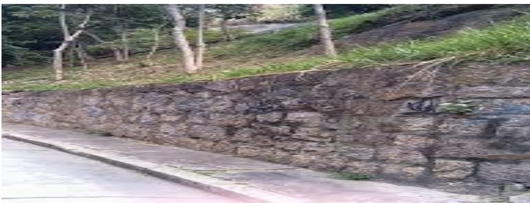
Photo I.04 : Murs poids en maçonnerie jointoyée(Jérôme Saliba 2017)
