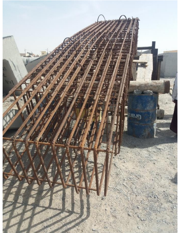
Photo IV.3: Collage de pieuxPhoto23 : Pieux après collage(ramasser des étudiant)
