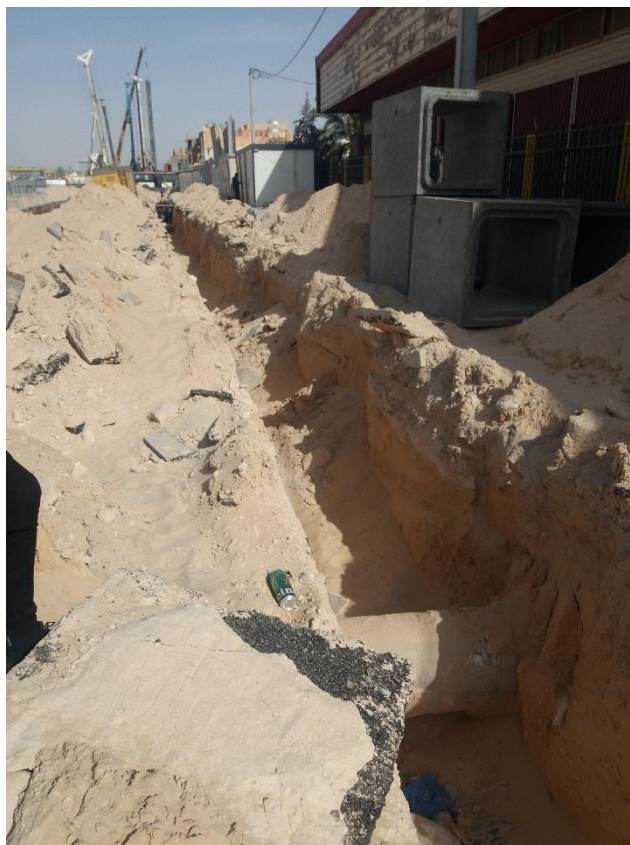
Photo IV.6: Raccordement le puisard avec le réseaux public d'assainissement(ramasser des étudiant)
