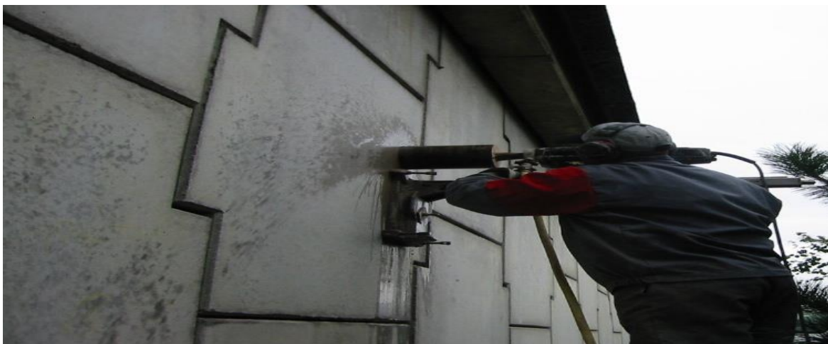
Photo I.14: Parement d'un remblai renforcé du procédé Terre Armée (AlKashi 2011)
