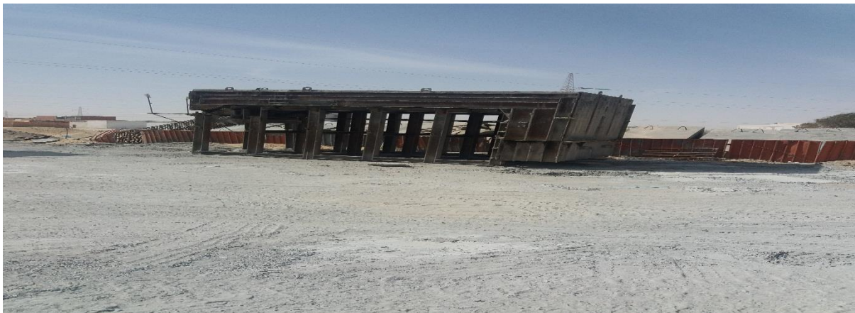
Photo IV.4: Ferrailage de murs de soutènement(ramasser des étudiant)
