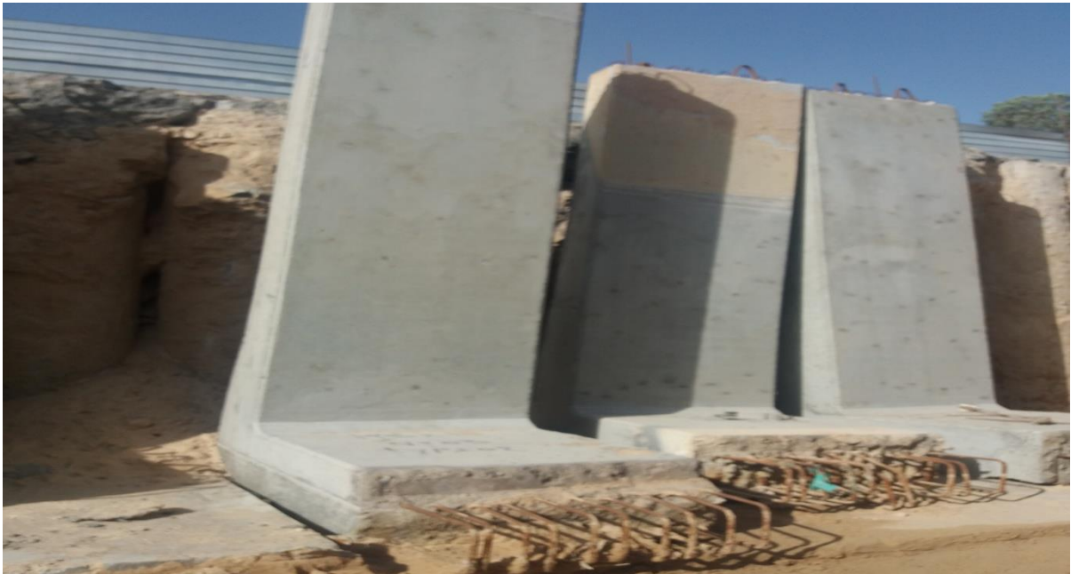
Photo IV.5: Collage de murs soutènement(ramasser des étudiant)
