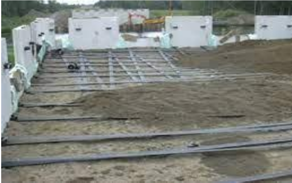
Photo I.15: Procédé Freyssin pour le sol : lit d'armatures en bandes géosynthétiques(AlKashi2011)
