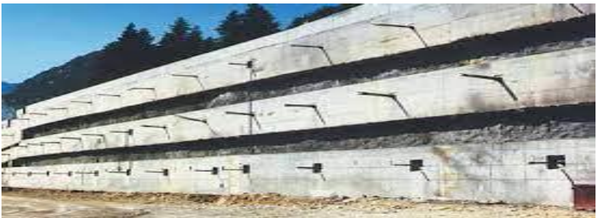
Photo I.19: Poutres ancrées en phase de construction (AlKashi 2011)
