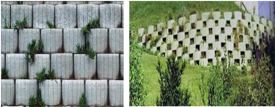
Photo I.07: Murs poids en éléments préfabriqués en béton empilés (chris2009)
