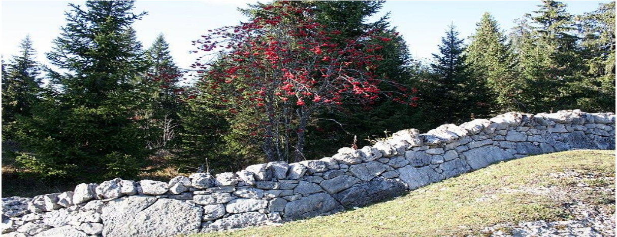
Photo I.03 : Murs poids en maçonnerie de pierres sèches(chris2009 )
