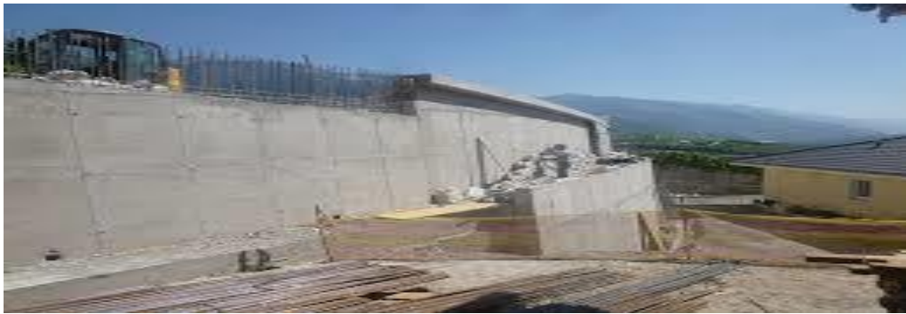
Photo I. 05 : Murs poids en béton ( Jérôme Saliba 2017)
