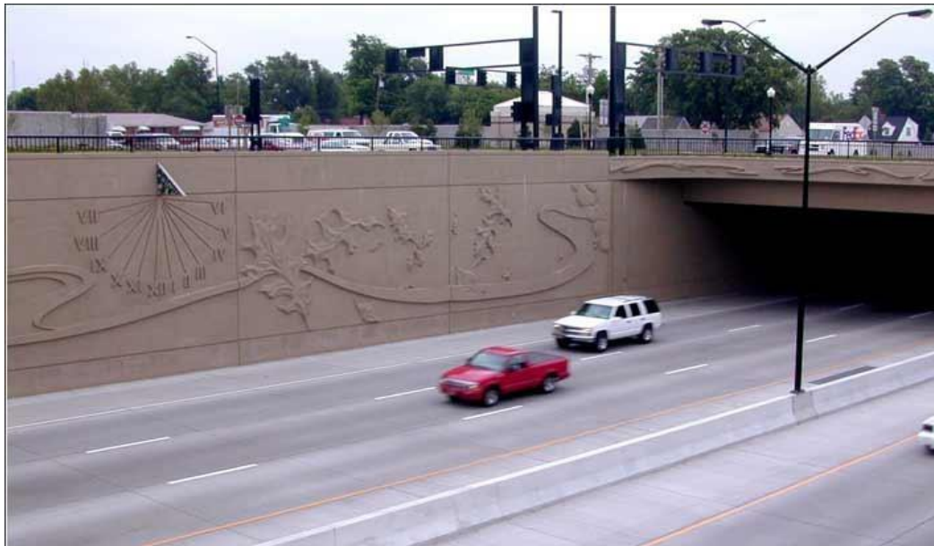
photo I.01: mur de soutènement(Adrien Lafond 2012)
