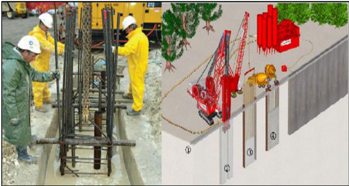
Photo I.11 : La paroi moulée( Khemoum2017 )
