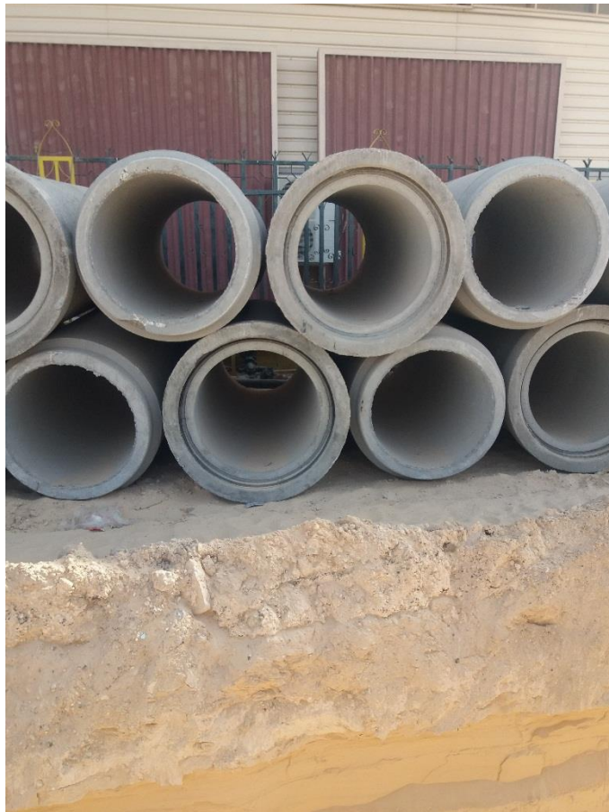
Photo IV.7: Canaux d'assainissement(ramasser des étudiant)
