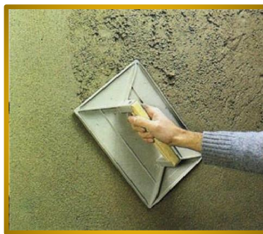
Figure I-7 : mortier de finissage.
