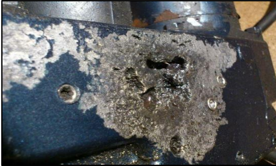
Figure III.4 corrosion par piqûres
