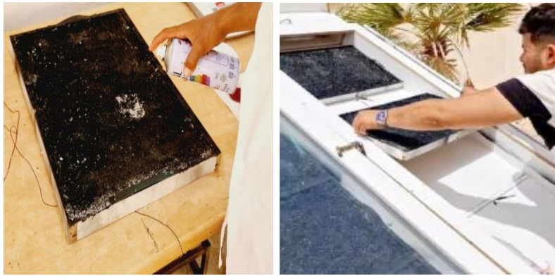
Figure (III- 33): l'installation de l'absorbeur étape 2
