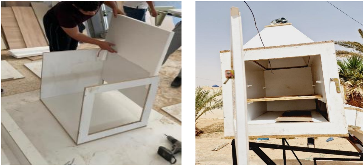
Figure (III- 21): Réalisation chambre de séchage
