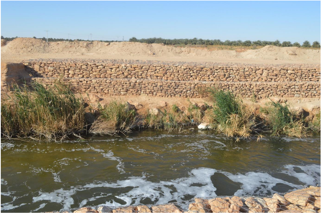
Photo IV-5 L'entretien des berges du canal - station sidi amrane
