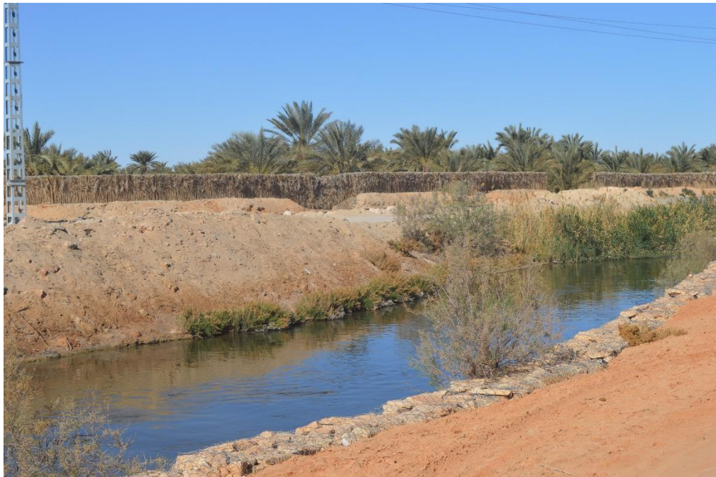
Photo III-2 canal principal du station Z. riab
