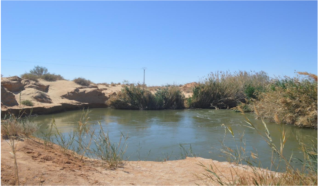
Photo IV-1 dégradation du canal région Boufeggoussa
