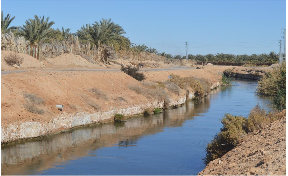
Photo IV-2 point de rejet des eaux sur le canal (station Z. riab)
