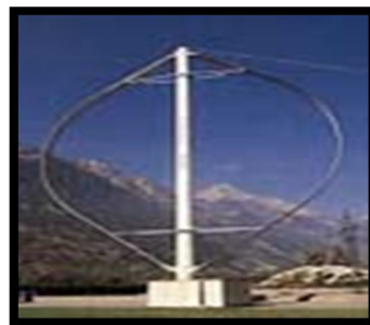
Figure I.8: Photographie d'une éolienne de Darrieus[11]
